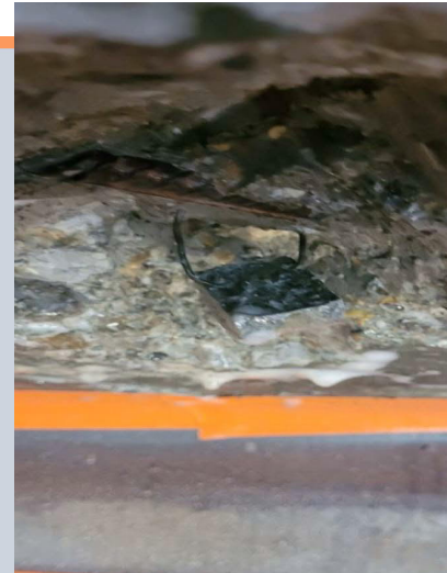
Abstandshalter mit „Rütteldraht“, BW 54-2s (AS Kempten) Foto Müller BBM 2025
