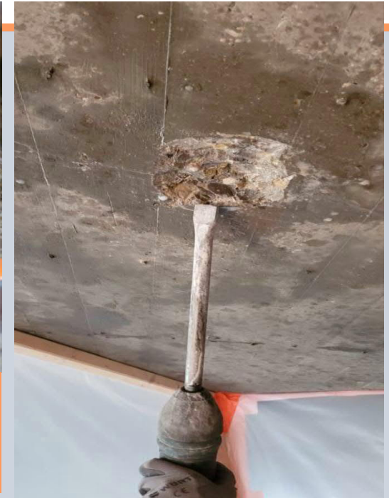
Stemmarbeiten am Abstandshalter im Überbau zur Simulation einer Faserfreisetzung beim konventionellen Abbruch, BW 54-2s (AS Kempten) Foto Müller BBM 2025
