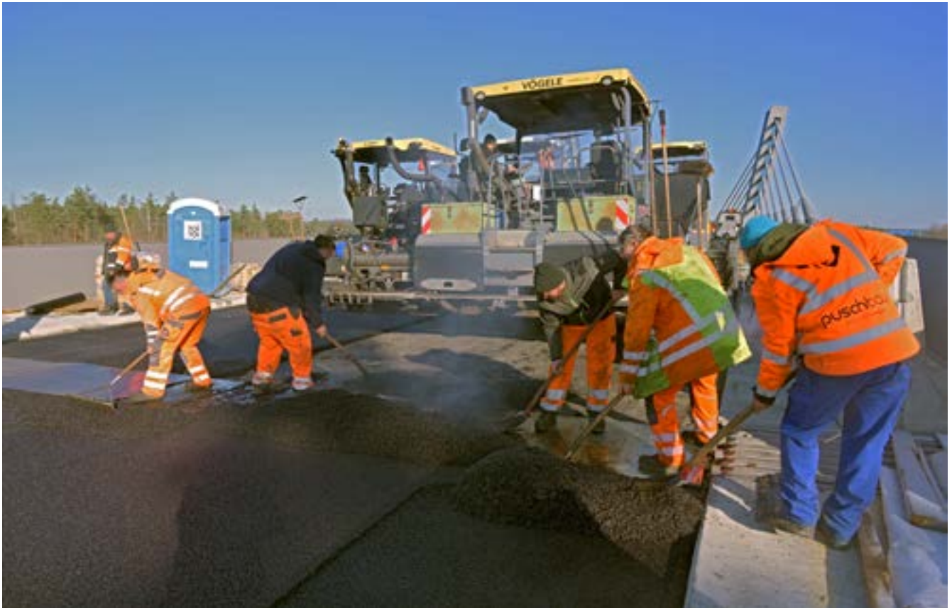
Bild 62: Deckschichteinbau auf Brücke
