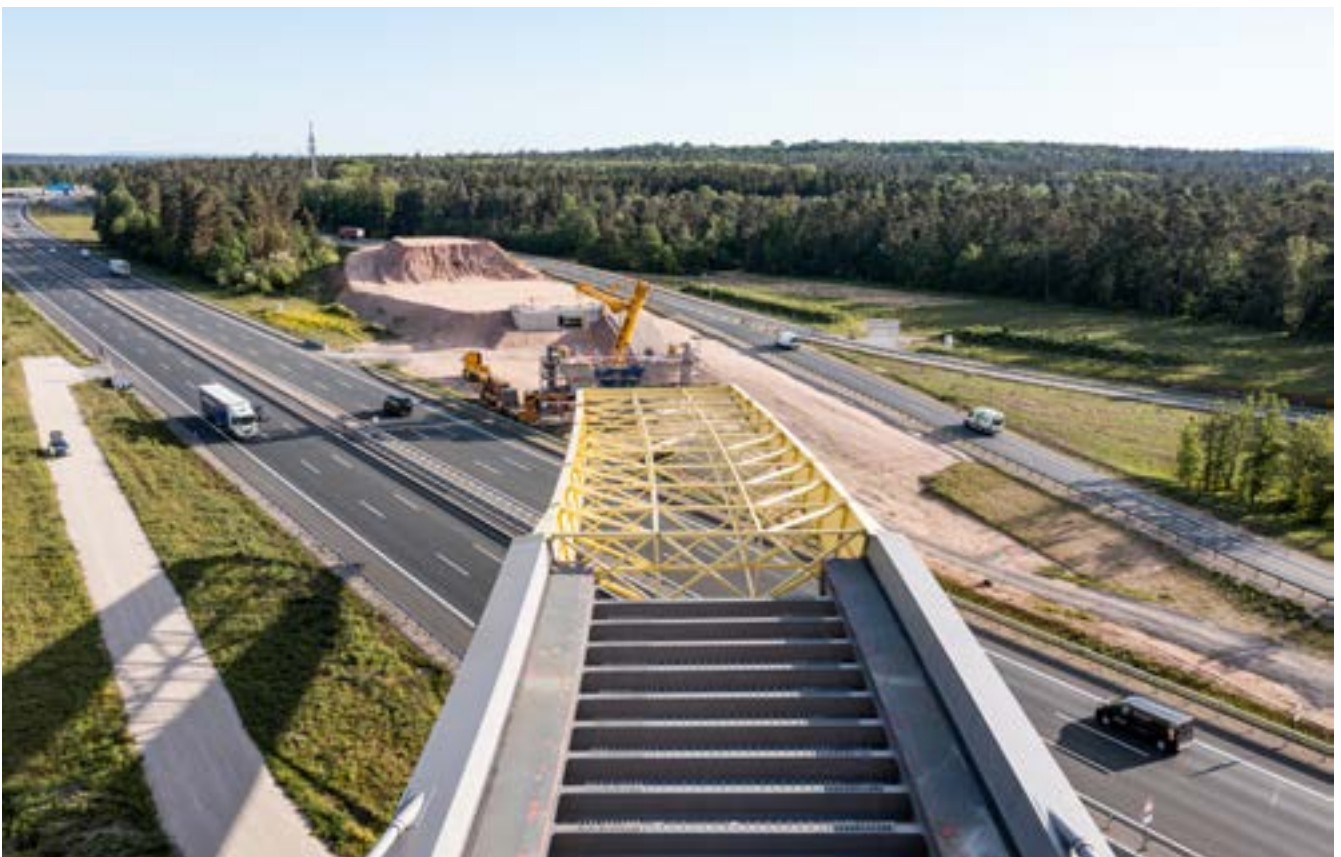
Bild 47: Verschubtakt 5 - Luftaufnahme vorderes Verschubfeld mit Vorbauschubbel
