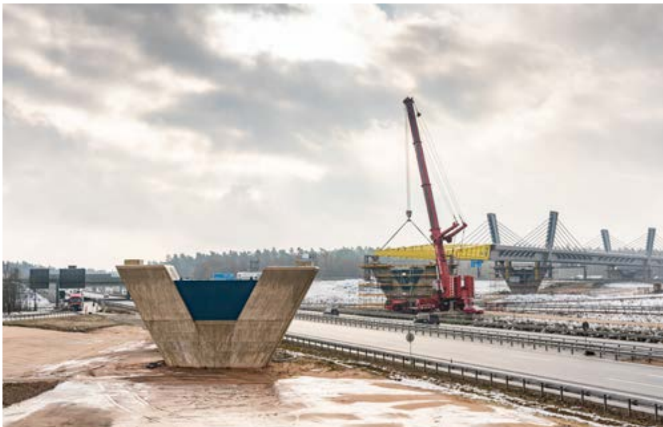
Bild 44: Verschubtakt 4, Tag 2 - Ansicht von Pfeilerachse 5
