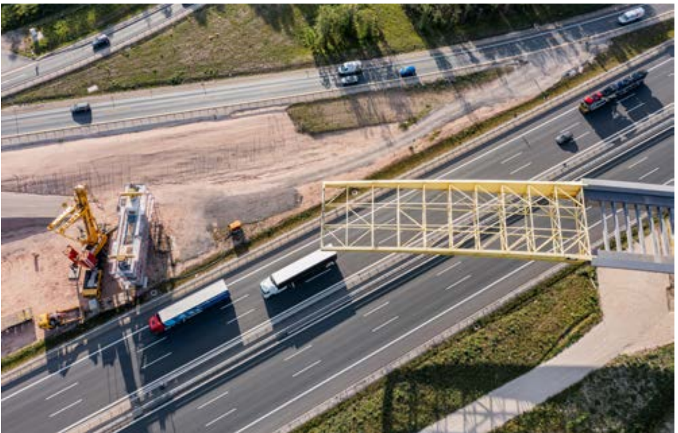
Bild 51: Vershubtakt 5 - Luftaufnahme über A9
