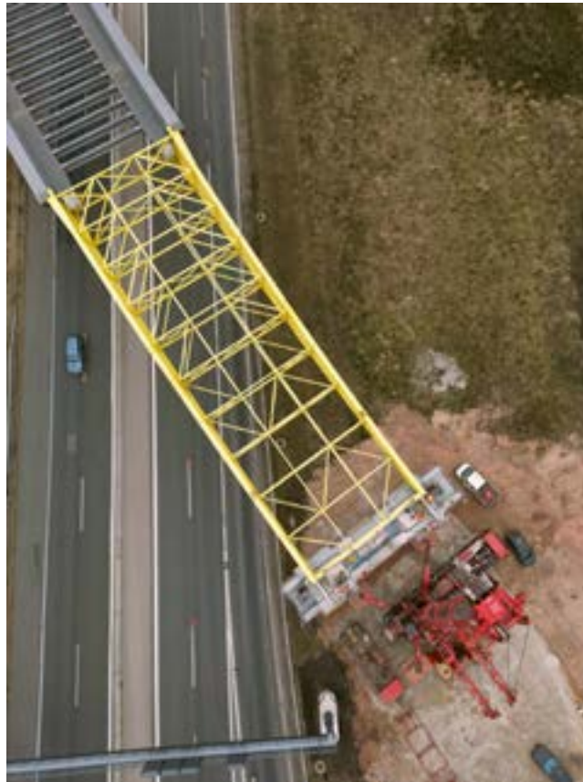
Bild 28: Verschubtakt 2 - Draufsicht Pfeilerachse 2
