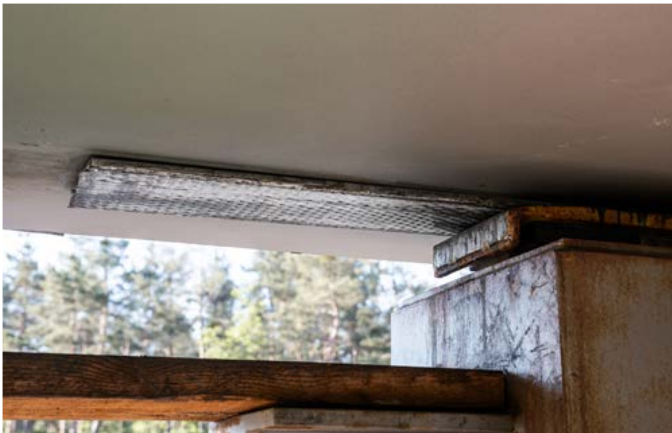
Bild 48: Verschubtakt 5 - Verschublager mit Teflongleitplatte
