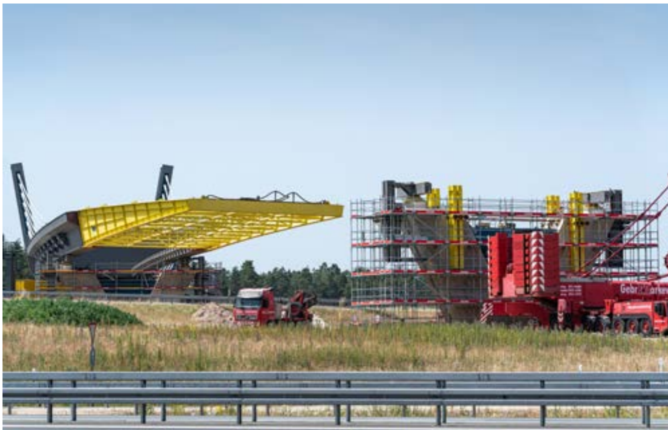
Bild 32: Verschubtakt 3 - Ansicht von Pfeiler 3
