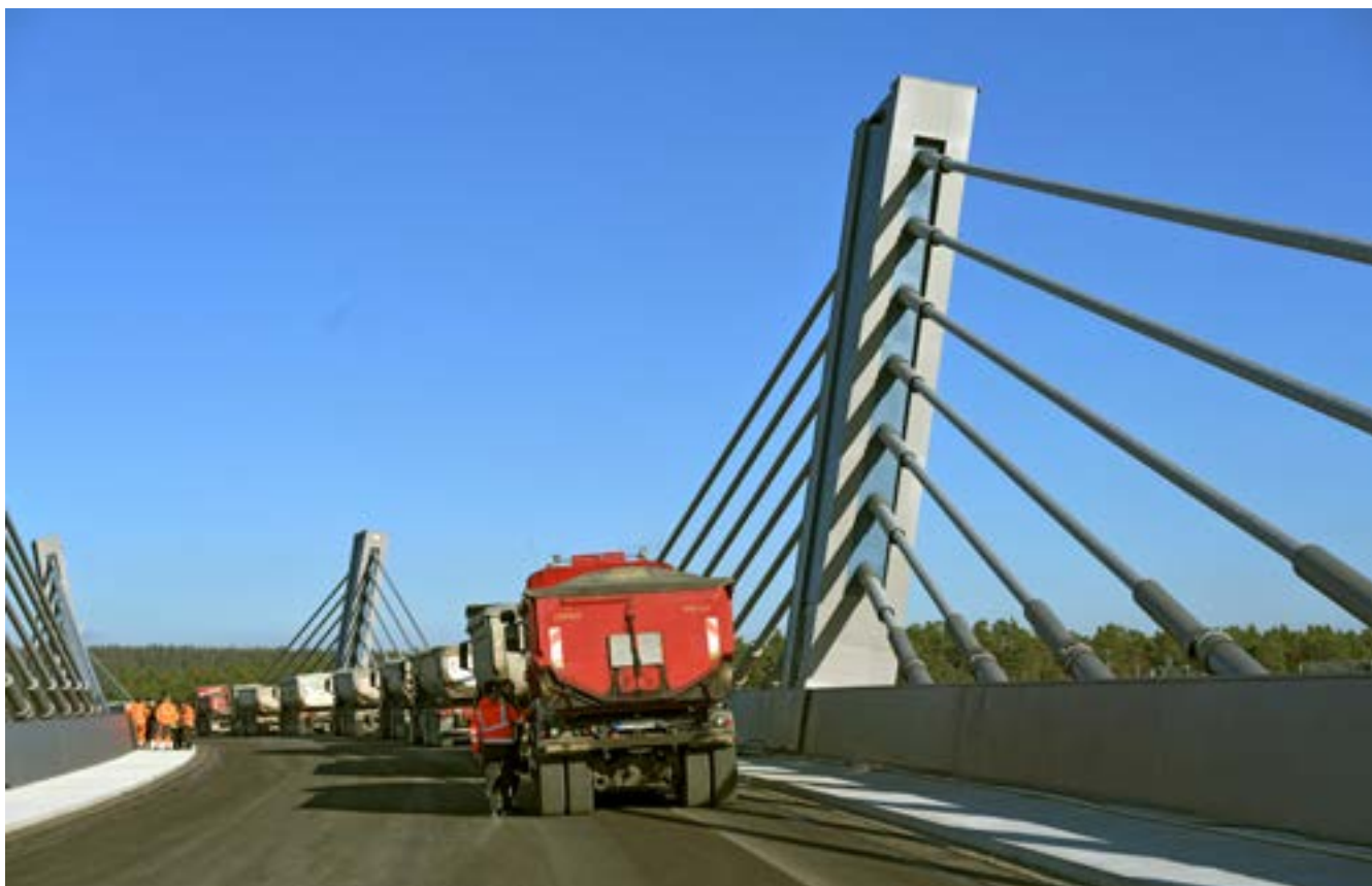
Bild 65: Deckschichteinbau auf Brücke
