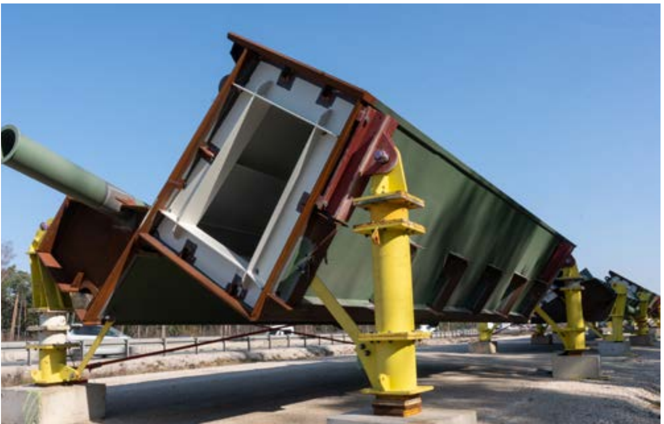
Bild 21: Längsträgerelement vor Einbau
