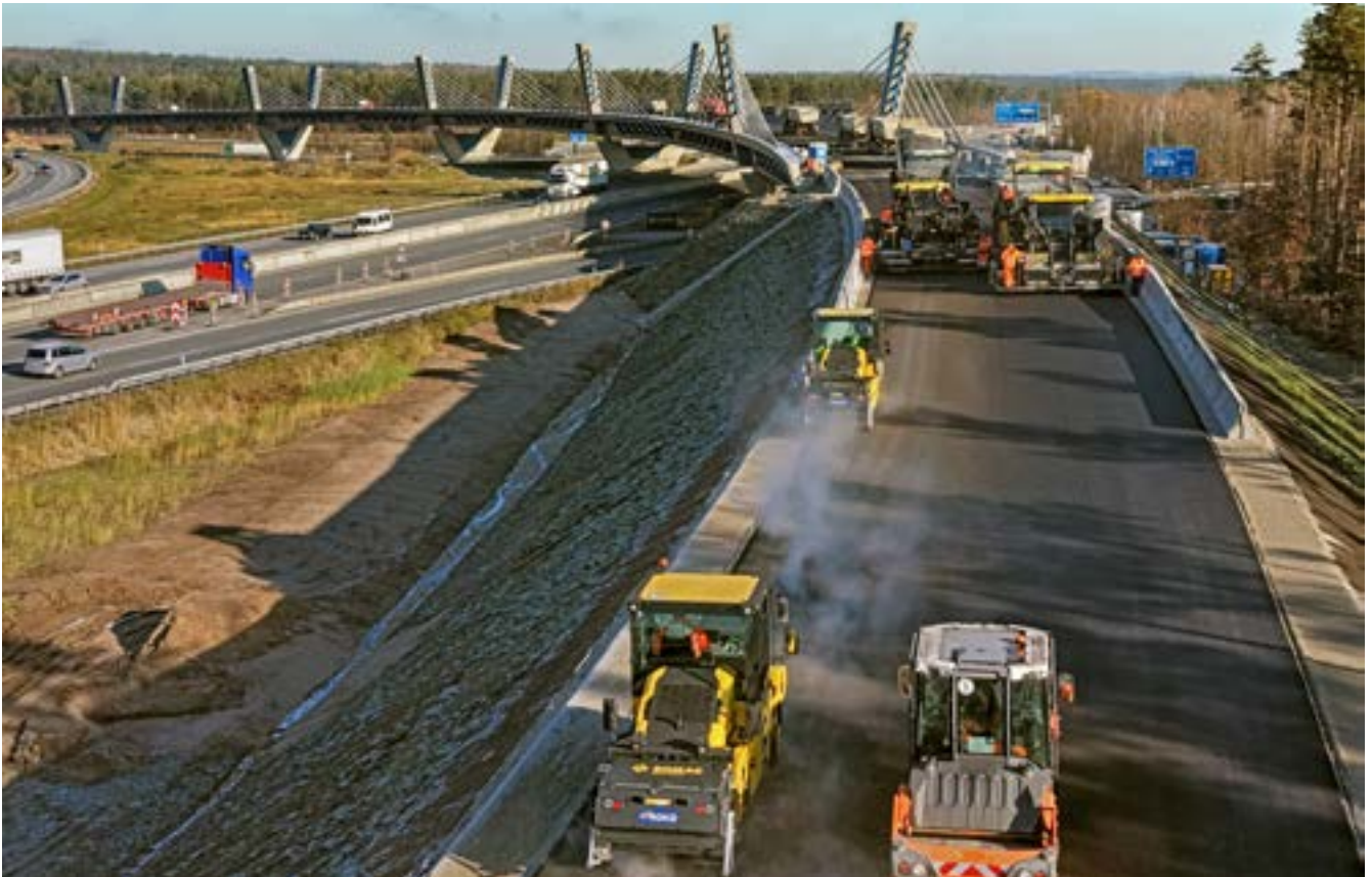
Bild 66: Deckschichteinbau
