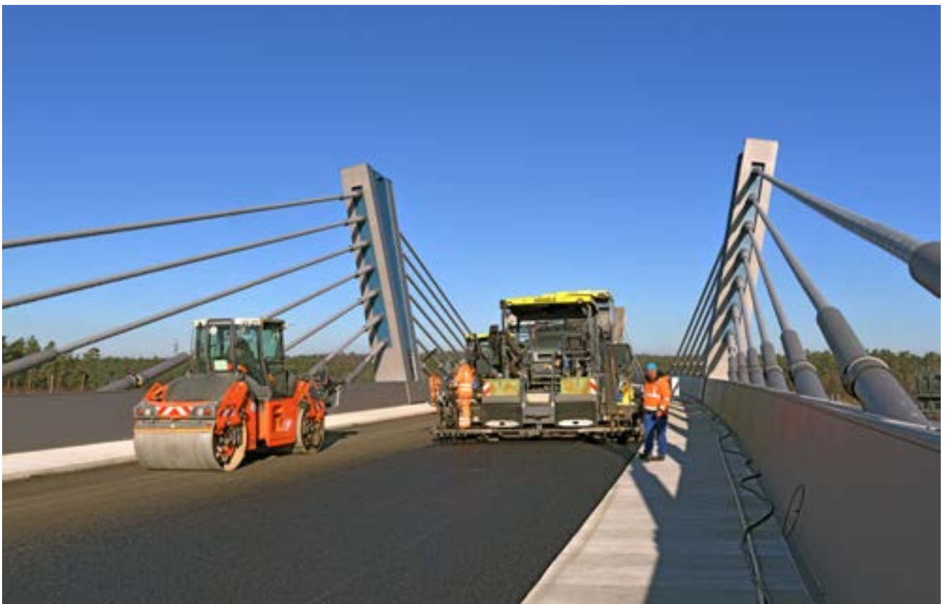
Bild 63: Deckschichteinbau auf Brücke
