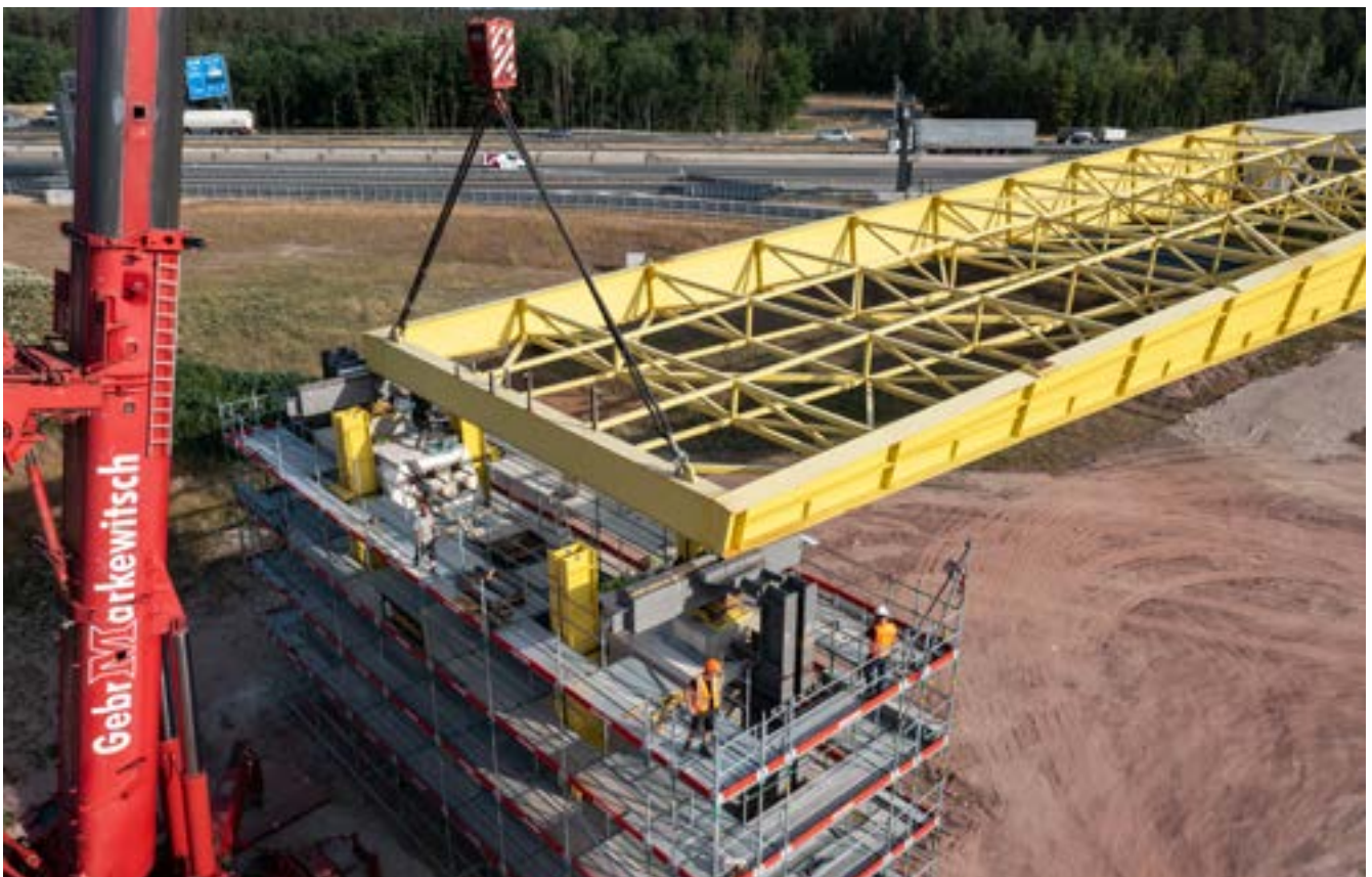
Bild 35: Verschubtakt 3 - Luftbild Auffahren Verschubwippe Achse 3
