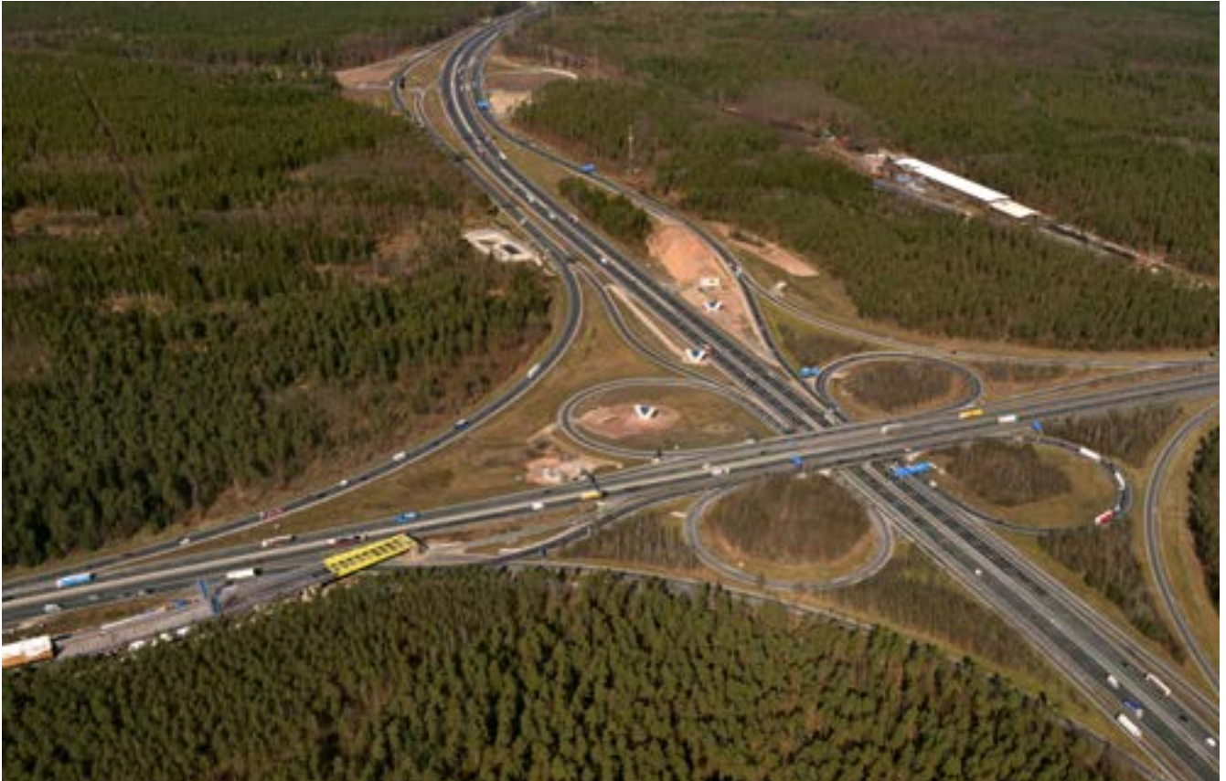
Bild 14: Luftbild Autobahnkreuz Nürnberg- Ost
