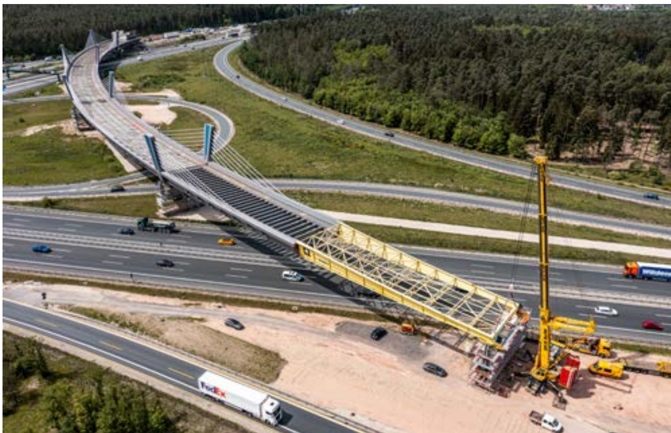
Bild 53: Verschubtakt 5 - Einfahren auf Pfeilerachse 5
