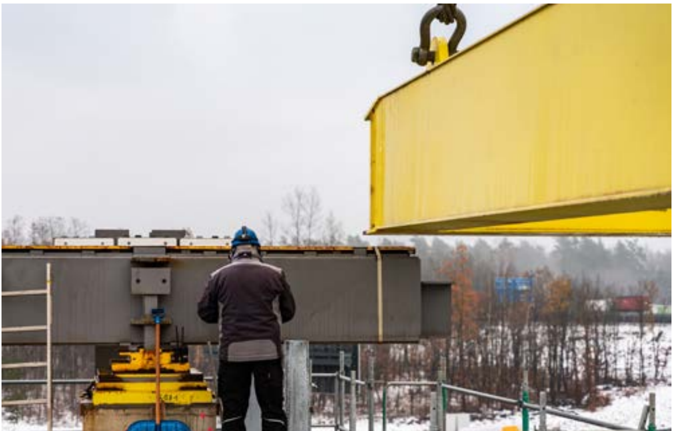
Bild 43: Verschubtakt 4, Tag 2 - Auffahren auf Verschubwippe
