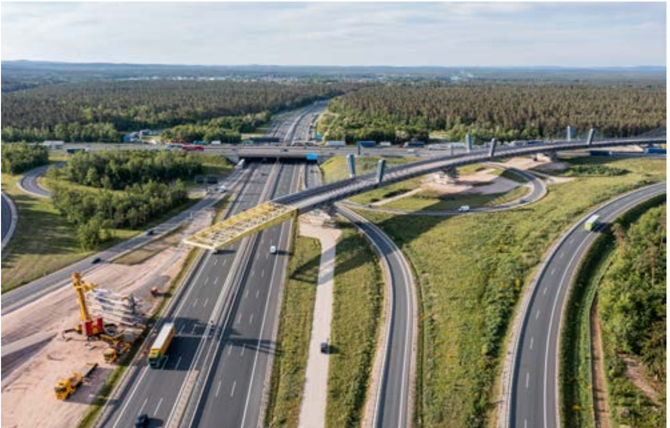
Bild 50: Vershubtakt 5 - Luftbild Blickrichtung Süden
