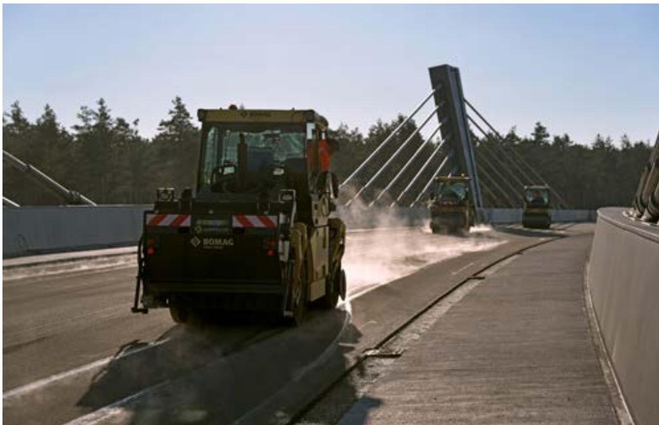
Bild 64: Deckschichteinbau auf Brücke
