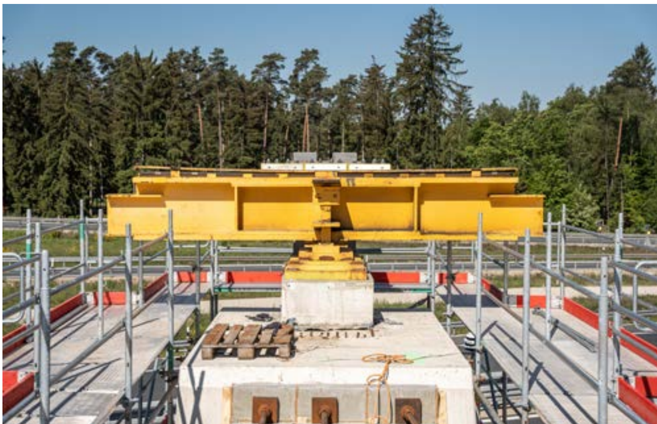
Bild 49: Verschubtakt 5 - Verschubwippe Achse 5
